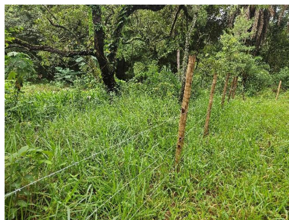
Cercamento iniciado – Fazenda Paulo Preto Autoria: Carolina Rodrigues Bordignon Data: 05/03/2024
